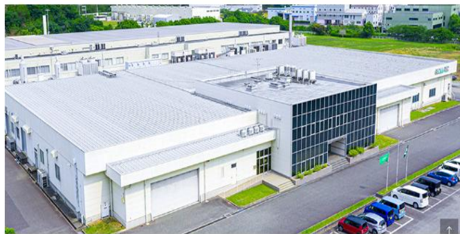
「HRDP 第一/第二ライン ジオマテック赤穂工場」
