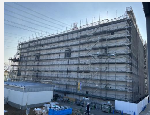
建設中の初期量産工場
