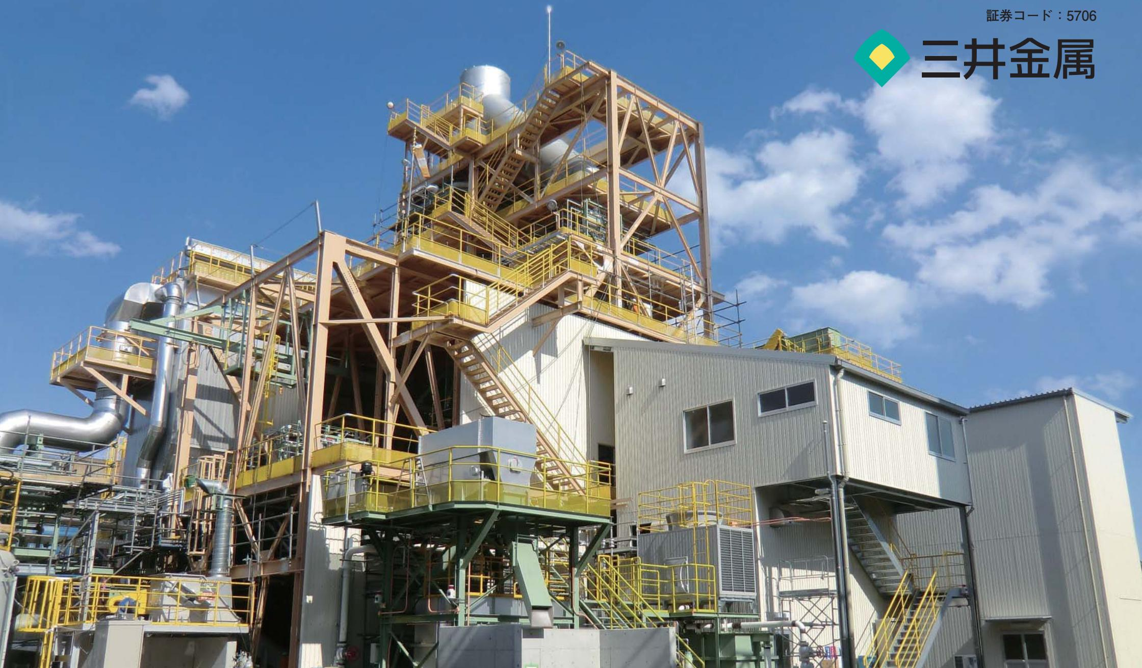
広島県にある竹原製煉所に新たに設置した廃基板からの有価金属回収設備、溶融キルン。
