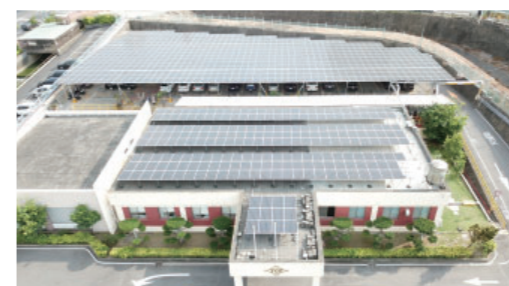
台湾銅箔 太陽光発電設備
