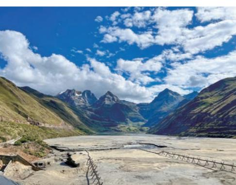
崩壊のリスクが小さいとされる外盛方式を採用しています。社内技術者による巡視や堤体水位のモニタリングに加え、外部機関による安定性評価を受けています。(ワンサラ鉱山、チュスピ鉱さい集積場)
