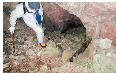
人が転落したりしないよう、陥没箇所を発見した場合には、埋設処理や柵を設置したりします。閉鎖した坑口の管理も十分にします。
