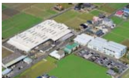
吉野川電線と現場の様子 (香川県高松市)
