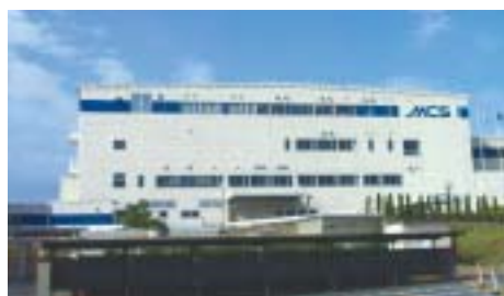
MCS社本社とTAB製造現場の装置 (山口県下関市)
