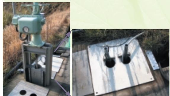
pH計と連動遮断弁の設置例
