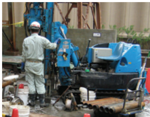
環境調査ボーリング
