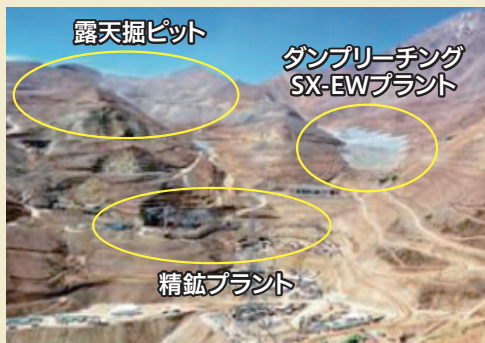
カセロネス鉱山全景
