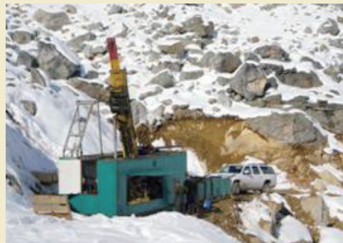
ラドッククリークボーリング作業
