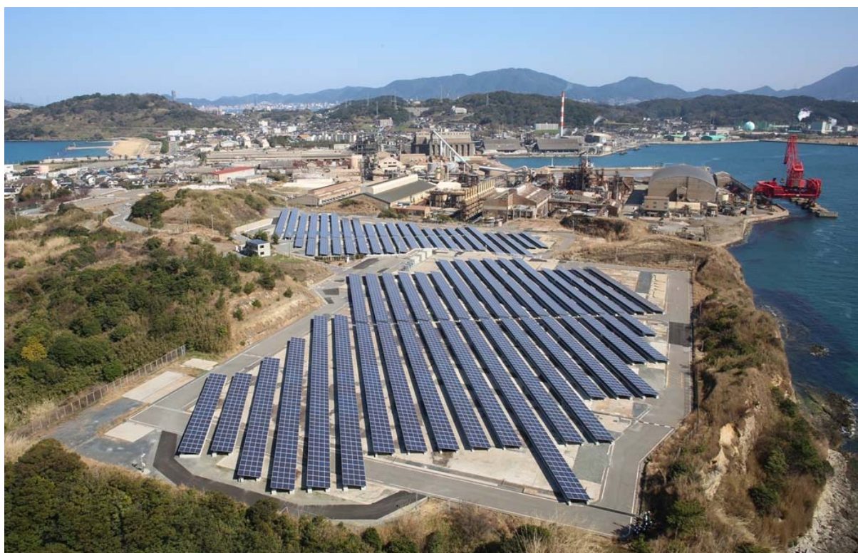
完成した彦島製錬太陽光発電所 全景
